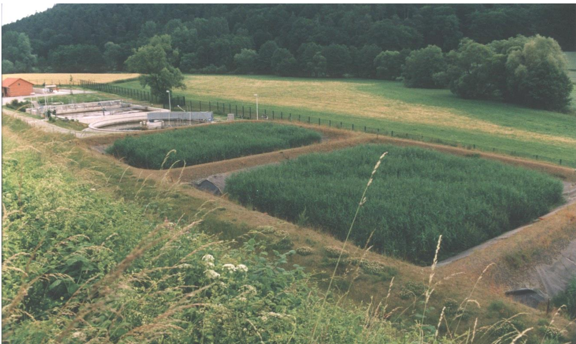
Klärschlammvererdungsanlage Naumburg Teilbeete 1 und 2 (2.400 m 2 Bruttofläche) Wuchshöhe bis 4 m; Halmdichte bis 320 Stück/m 2 , Belebungsanlage im Hintergrund
