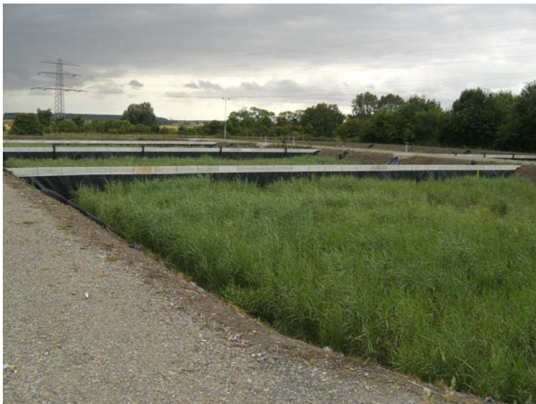
Klärschlammvererdungsanlage Groß Lafferde
