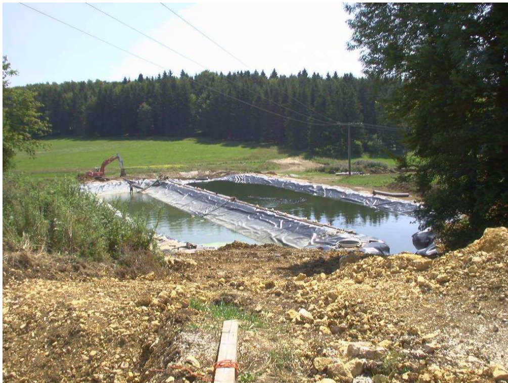
Foto: Becken im Rohbau
